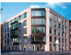
BIUROWIEC PRZY SKRZYŻOWANIU UL. BUKOWSKIEJ I KRASZEWSKIEGO
