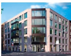
BIUROWIEC PRZY SKRZYŻOWANIU UL. BUKOWSKIEJ I KRASZEWSKIEGO
