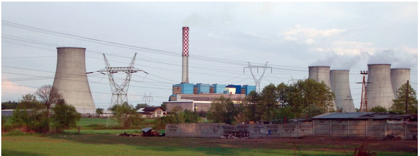
Turek - elektrownia Adamów Źródło: http://pl.wikipedia.org Autor: Jakub Łuczak
