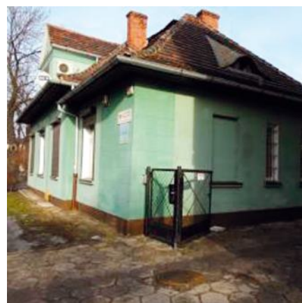
Nieruchomość zabudowana położona w Poznaniu przy ul. Kolejowej 4a Źródło: http://pkpsa.pl/nieruchomosci/
