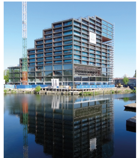
Bydgoszcz, apartamentowiec Nordic Haven (w budowie – 2016); Źródło: http://pl.wikipedia.org ; Autor: Pit1233
